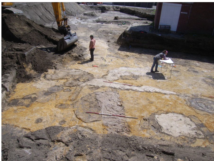
Afb. 4.3 Impressie van de werkzaamheden tijdens het veldwerk in deelgebied 2A.
