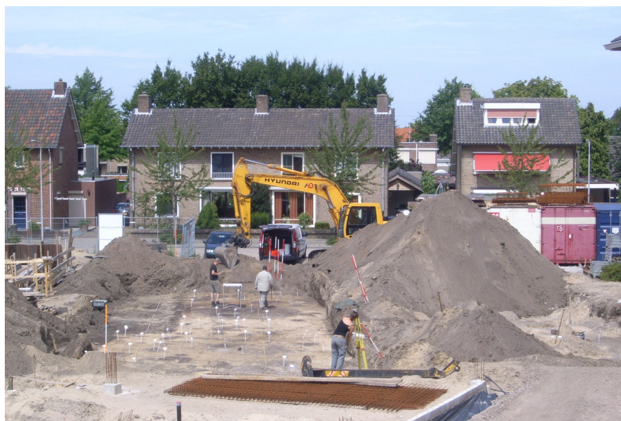
Afb. 4.1 Impressie van de werkzaamheden tijdens het veldwerk in de deelgebied 1.
